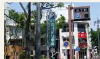
新豊田駅地下駐車場 (一社)豊田市身障協会)
